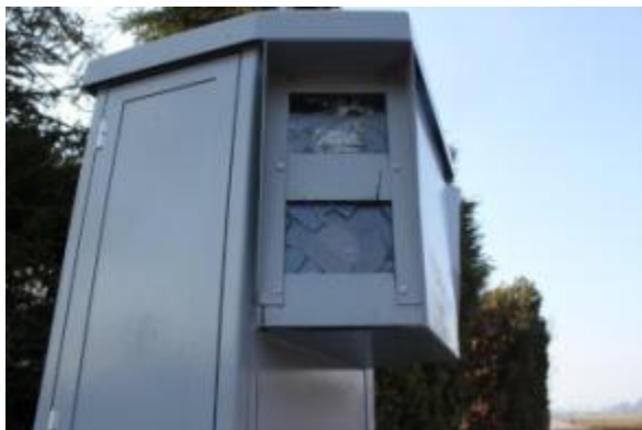
Vandalismus am „Blitzli“
