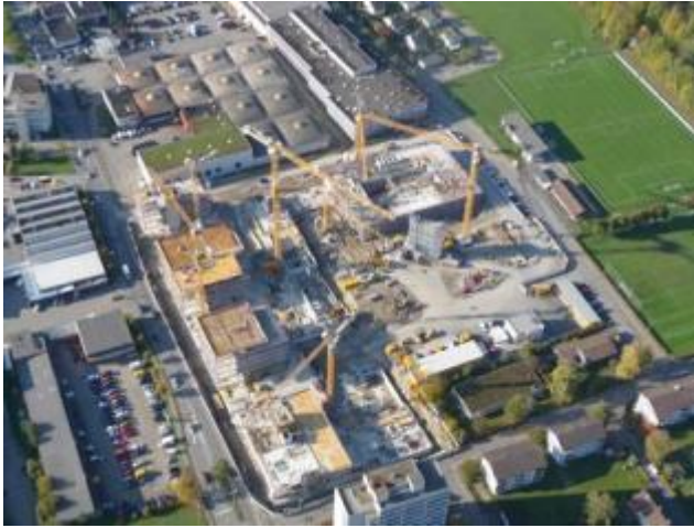
Baustelle Verwaltungszentrum Neumatt
